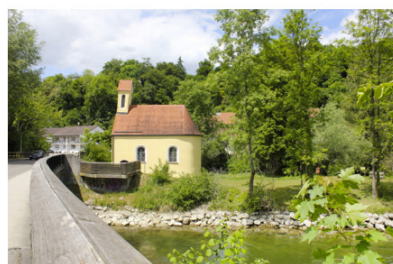
St. Nikolauskapelle an der Amper
