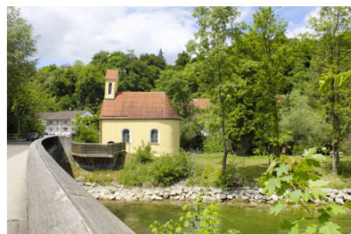
St. Nikolauskapelle an der Amper
